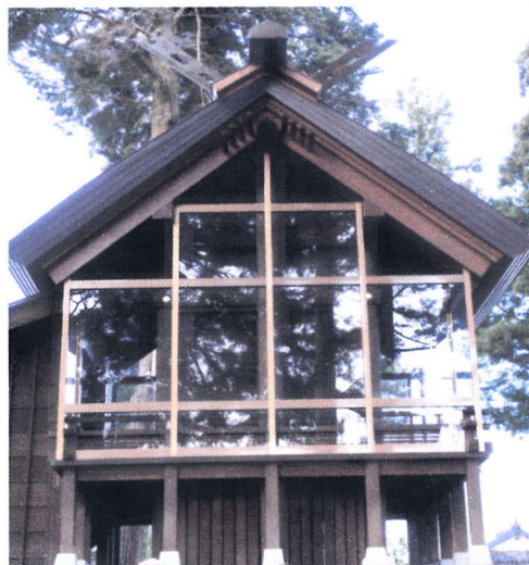
修復された本殿
