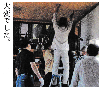
灯籠の配線確認
