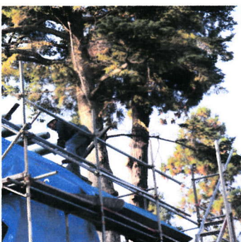
本殿屋根の修理
